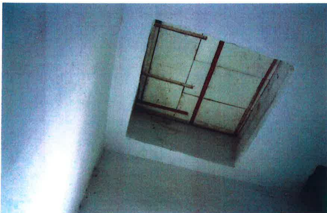
Pompownia centralna – wyjście na dach
