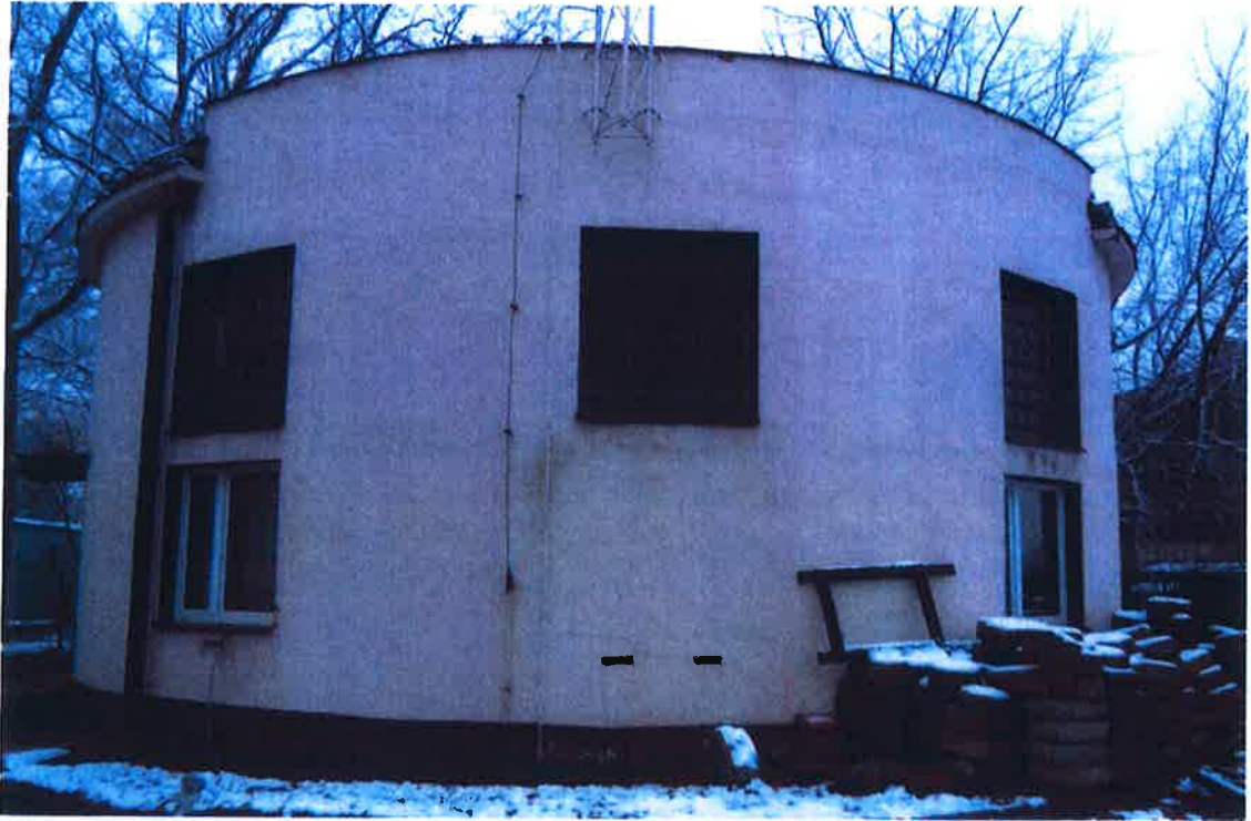
Pompownia centralna – elewacja południowa
