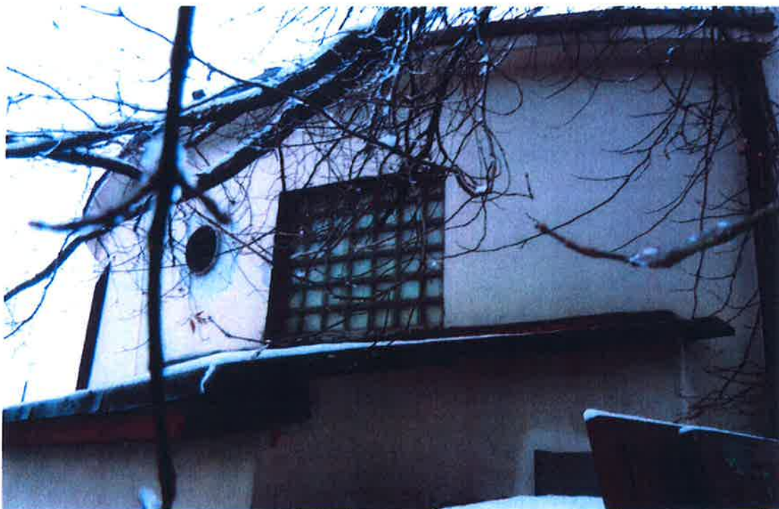
Pompownia centralna – elewacja zachodnia
