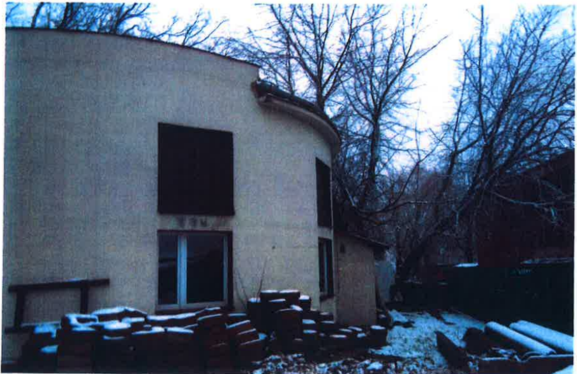
Pompownia centralna – elewacja wschodnia
