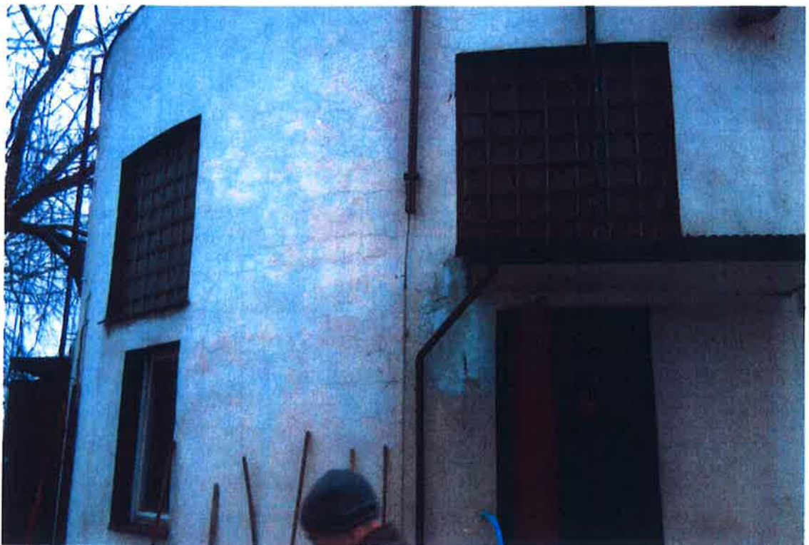
Pompownia centralna – elewacja południowa
